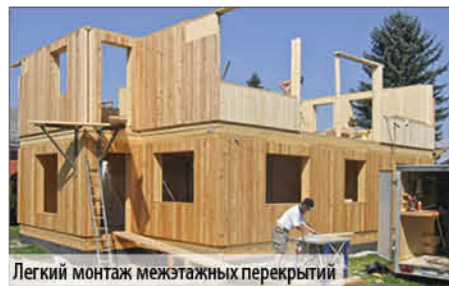
Легкий монтаж межэтажных перекрытий
