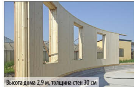
Высота дома 2,9 м, толщина стен 30 см
